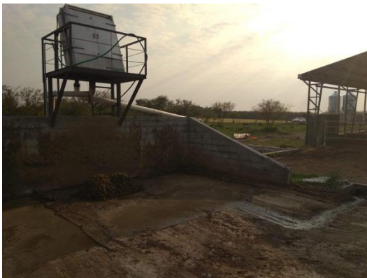
Figura 5. SGE en Campo Experimental N°2, Facultad de Veterinaria, Libertad. a) Pozo de bombeo con revolvedor mecánico y bomba estercolera, b) Separador de sólidos mecánico (extrusora), c) Pileta de almacenamiento impermeabilizada.
